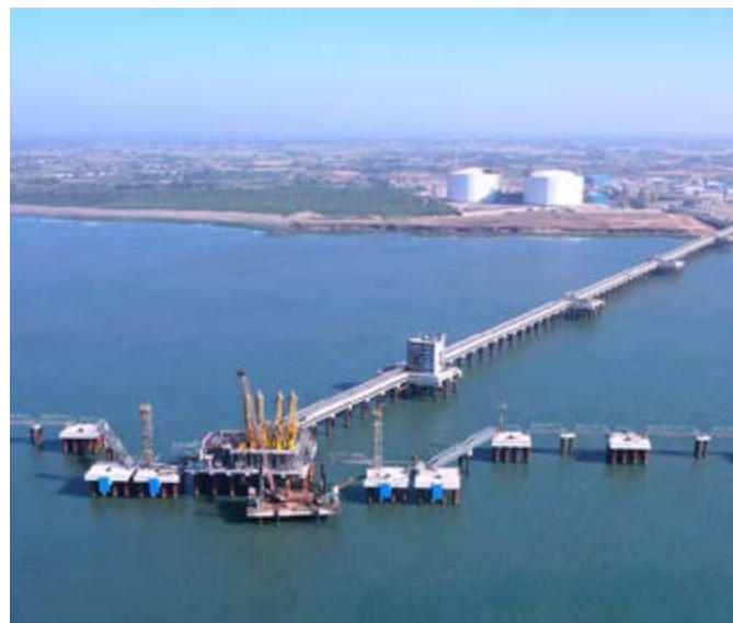
Chhara LNG Terminal
